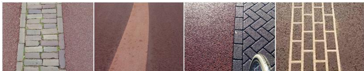
Figuur 9: Verschillende oplossingen voor rabat- en middenstroken. V.l.n.r. klinkers in stevig bed, afwijkende toplaag, streetprint en een combinatie van streetprint en markering.
