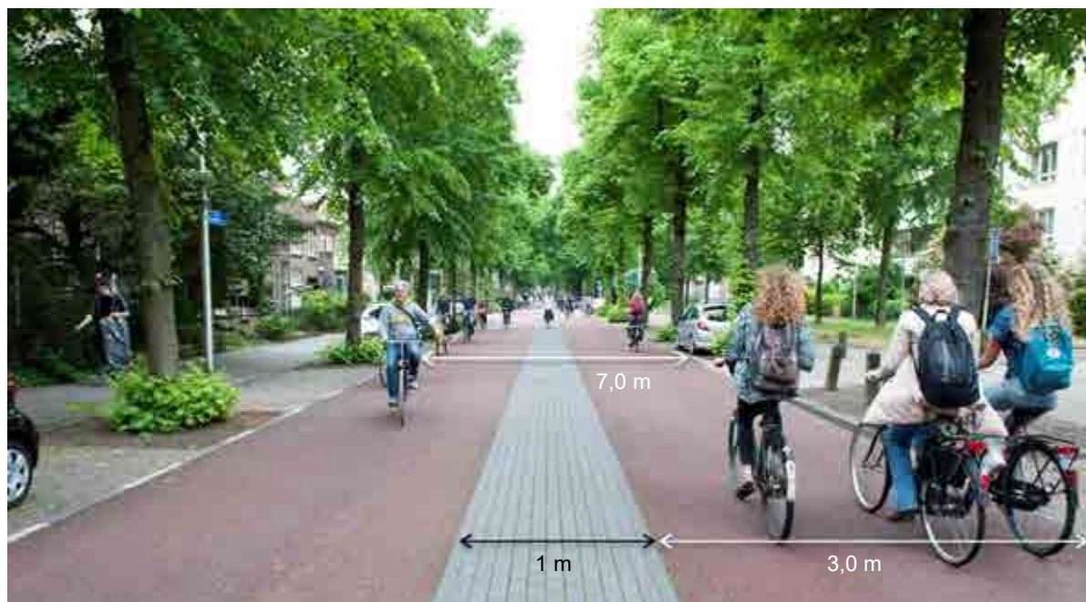
Figuur 6: Voorbeeld van een brede fietsstraat met een hoge fietsintensiteit. De rijloper is aan de brede kant, waardoor fietsers makkelijk met z'n drieën naar elkaar kunnen fietsen (zie ook paragraaf 4.2)
